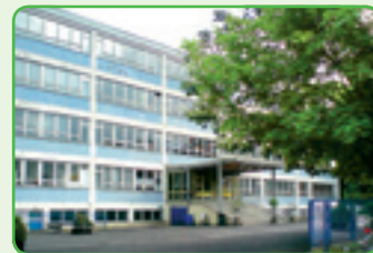
Der zukünftige Standort des CSM an der Stollberger Straße - im Sommer kann der Umbau losgehen.
